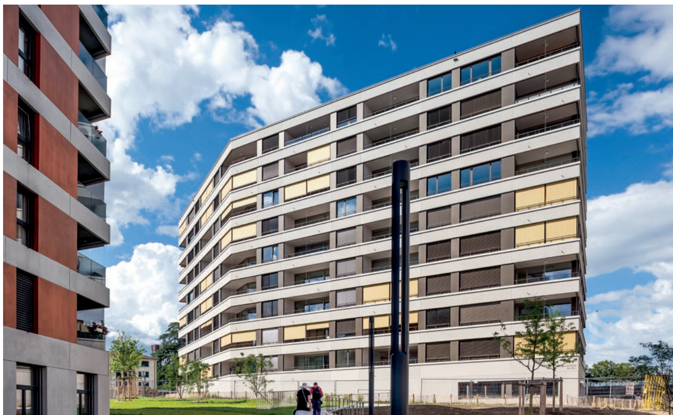
RUE LOUISA-VUILLE 6 ET 8 – FAÇADE PRINCIPALE
